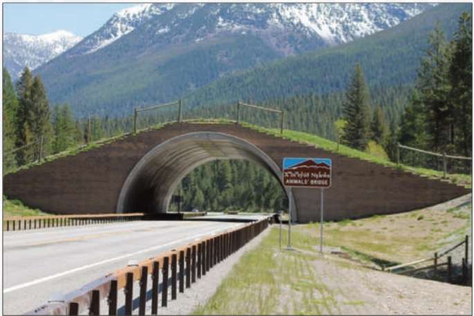
Figura 98: Ponte per passaggio fauna.
