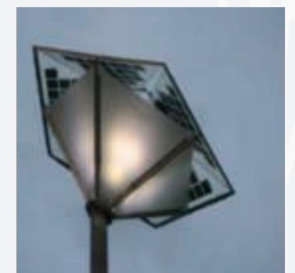
Figura 18: Esempi di nuovissimi pali di illuminazione totalmente fotovoltaici.
